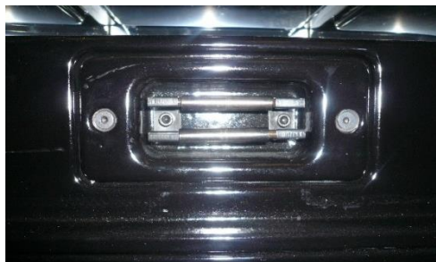
Figura nº21 - Acessos para a limpeza da saída de fumos.
